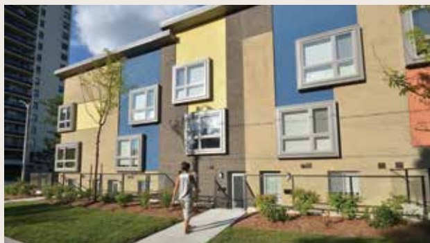
Exemple de logements de type intermédiaire : des maisons de ville superposées à Kitchener.
