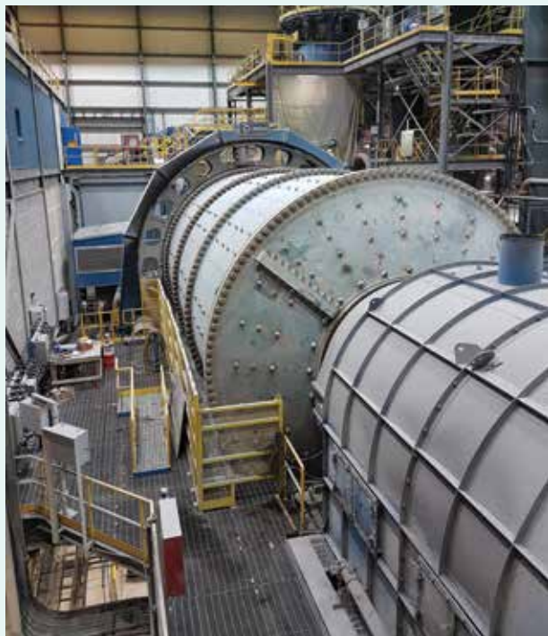
Broyeur semi-autogène à l'usine de traitement du minerai de LSG, un des équipements les plus énergivores de cette usine.
