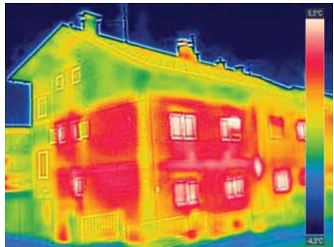
Figure 3.5. L'image thermique d'une résidence montre les endroits où la chaleur s'échappe. La couleur rouge indique des températures élevées, ce qui signifie que ces zones de la maison laissent s'échapper davantage de chaleur. Les zones jaunes et vertes de la maison sont mieux isolées et perdent moins de chaleur.
