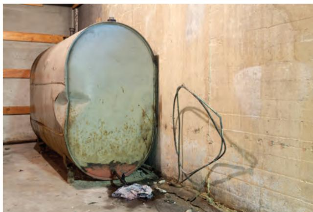
Exemple de réservoir de mazout de chauffage résidentiel mal entretenu dans un sous-sol.
