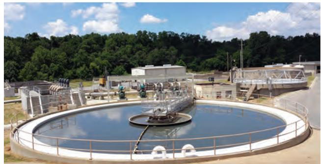
De nombreuses composantes d'une usine de traitement des eaux usées peuvent être surchargées par de fortes précipitations ou la fonte rapide des neiges, causant ainsi des débordements et détournements. En image, un bassin de décantation, élément clé du processus primaire de traitement des eaux usées.
