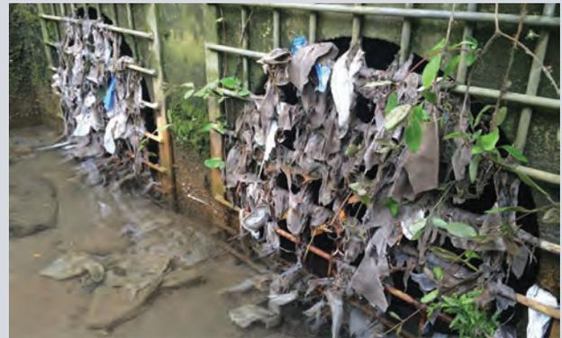
Débris provenant d'un débordement d'eaux usées accrochés à une grille qui recouvre un tuyau d'écoulement.
