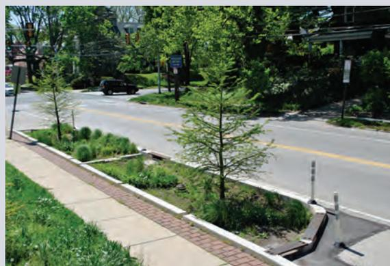
Les zones perméables comme ce terre-plein central détournent l'eau des réseaux d'égouts pluviaux ou unitaires des municipalités en permettant à davantage d'eau d'être absorbée dans le sol.
