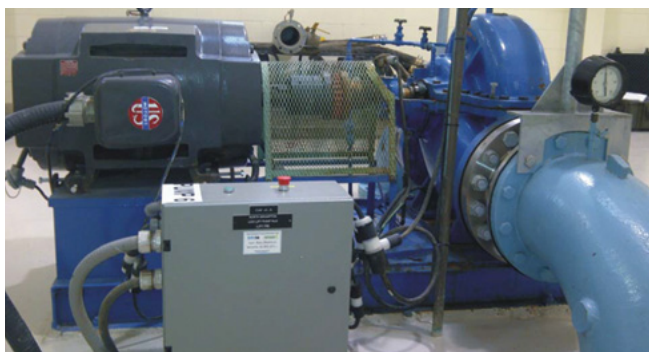
Un moteur et une pompe à une station de pompage dans la région de Peel Source : A Pump Efficiency Assessment and Awareness Pilot Study , Hydratek, 2013.
