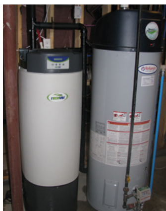
Réservoir des eaux grises (gauche) pour les réutiliser dans les usages domestiques. Source : Municipalité régionale de Durham.
