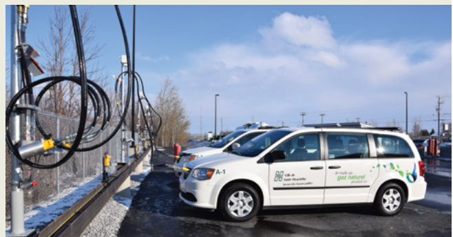
Poste de ravitaillement au biogaz pour les véhicules au gaz naturel.
