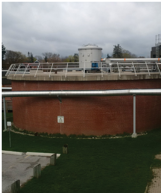
Digesteur anaérobie de l'usine de traitement des eaux usées de la ville de Barrie.
