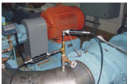
Test thermodynamique pour mesurer l'efficacité d'une pompe. Source : Hydratek.
