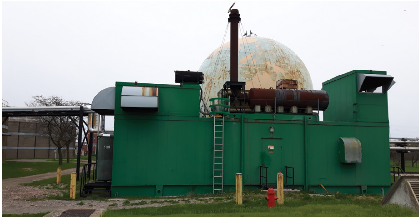
Équipement de production combinée de chaleur et d'électricité et réservoir de biogaz de la ville de Hamilton. Source : Ville de Hamilton.
