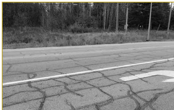
Route datant de six ans présentant des fissures prématurées à Coldwater (Ontario).
